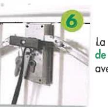
6 La porte est équipée d'une serrure de sécurité à double verrouillage avec cylindre européen.
